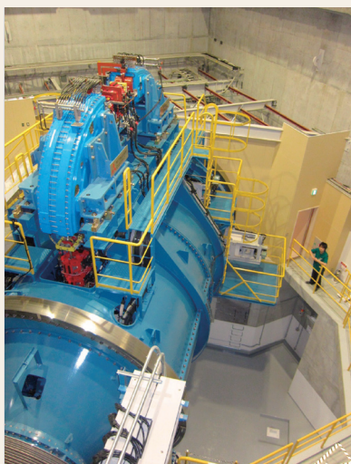
(メディアポリス国際陽子線治療センター 回転ガントリー)
