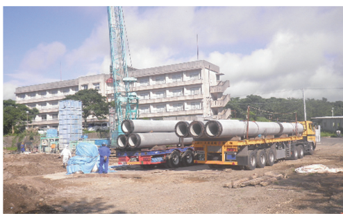
本杭工事 (平成28年7月上旬頃)
