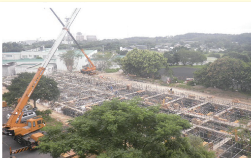
基礎工事 (平成28年8月中旬)
