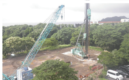
本杭工事 (平成28年6月下旬頃)
