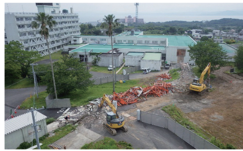
渡り廊下解体風景 (平成28年5月頃)
