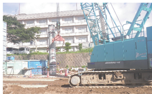
本杭工事 (平成28年7月上旬頃)
