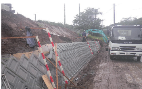
擁壁工事 (間地ブロック) (平成28年6月上旬頃)
