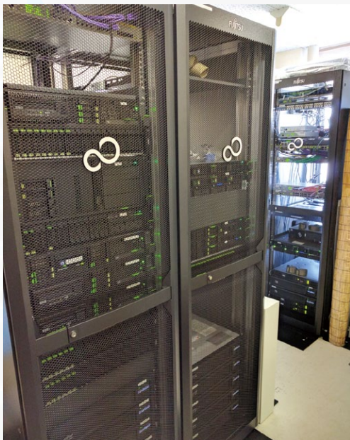
サーバールーム 電子カルテサーバ関連ラック
